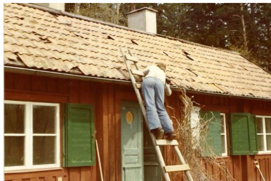
På bilden t.h. inspekterar Ulla Boije trasiga tegelpannor
